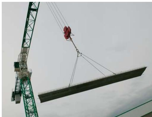
Il solaio a lastre tralicciate PREDALLES, abbinando una notevole riduzione dei tempi di esecuzione in cantiere ad una rilevante flessibilità compositiva, trova largo impiego nella realizzazione di orizzontamenti in strutture per l'edilizia civile, sociale e commerciale, specie per scantinati ed autorimesse.
